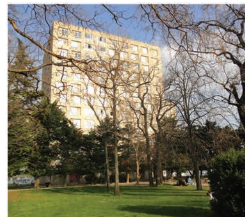
4 La Barbière en 2010 avant l'opération de réhabilitation.
