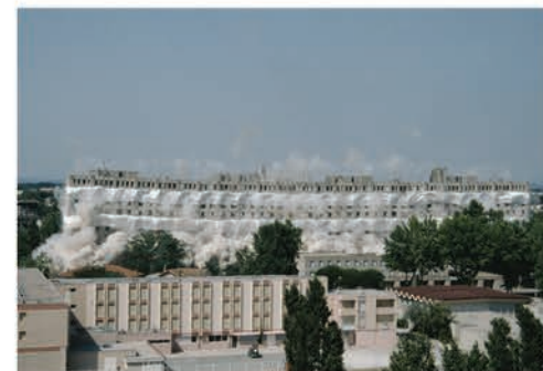
3 Démolition de la barre d'immeubles de Champfleury en juillet 1994.
